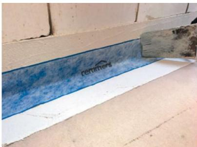
**4 Hidroizoliacinė juosta „Tape VF“**
